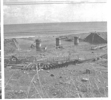
流された宿戸地区大浜の鉄橋
