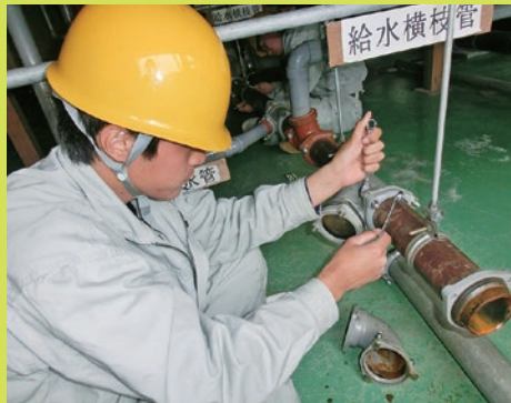
実 習(配管作業)
