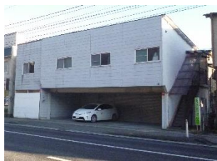
国道側からの外観
