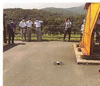
ドローンによる祭時大橋調査
