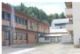
新校舎と実習棟の間
