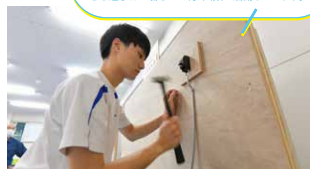
総合文化部 電気工事部門
