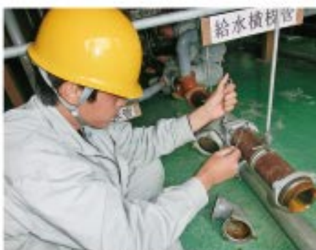
実習(配管作業)
