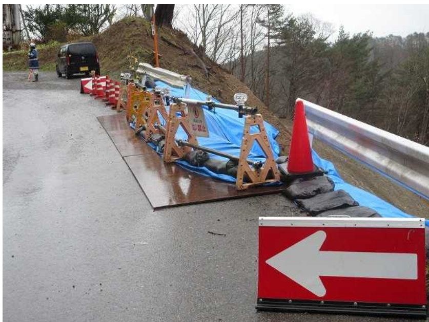
崩れた道路に鉄板を敷いて補強しています。
