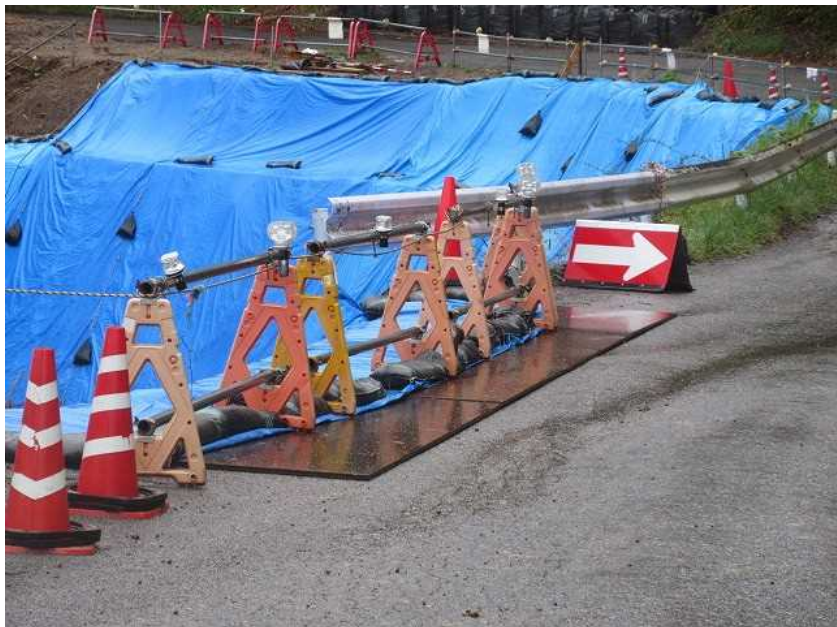
崩れた道路に鉄板を敷いて補強しています。
