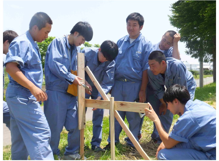
路線測量にて丁張りをしている様子です。
