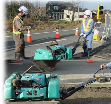
下水管工事後の道路補修工事体験
