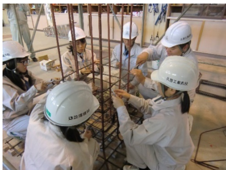
鉄筋の組立実習
