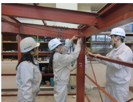
鉄骨の組立実習
