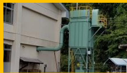
集塵機更新 実習環境が改善されます
