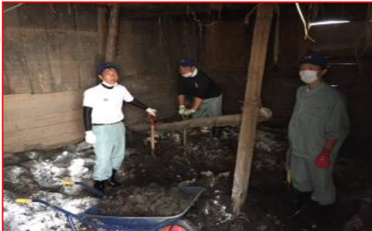
屋内の土砂出し作業
