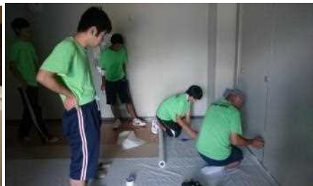
「高等部相撲ボランティア」 体育館全面のシート貼り
